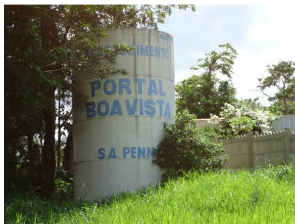
Figura 42. Vista do Reservatório R07
