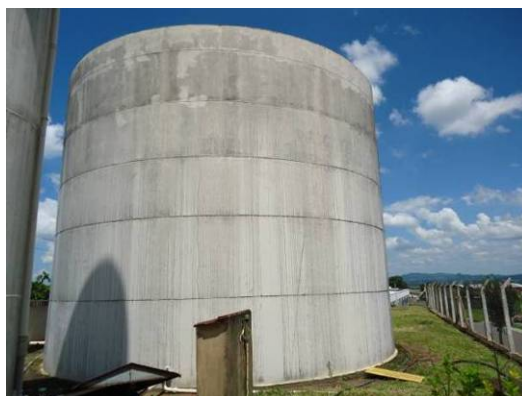
Figura 39. Vista do Reservatório R04
