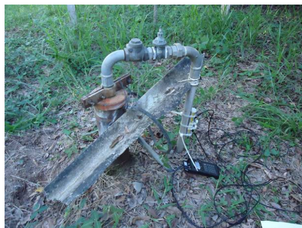
Figura 86. Vista durante a medição 04
