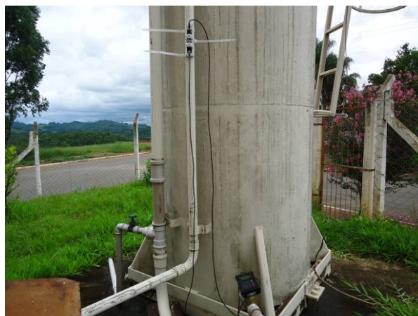
Figura 84. Vista durante a medição 02
