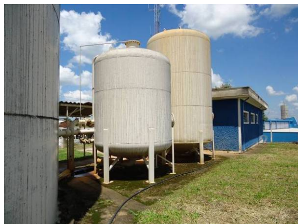
Figura 31. Vista da ETA II
