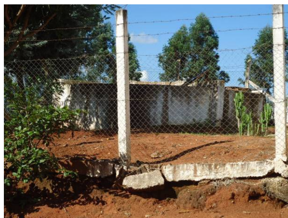
Figura 55. Vista do Reservatório R18
