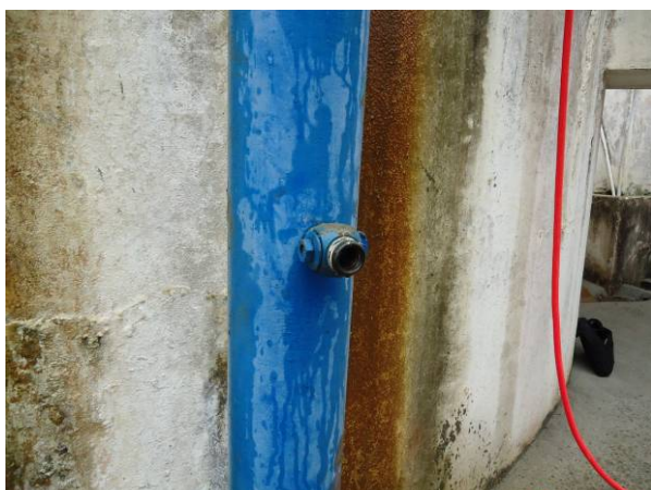
Figura 89. Vista da Estação Pitométrica Existente
