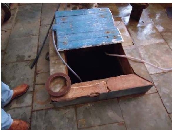
Figura 26. Vista do Reservatório de Sucção
