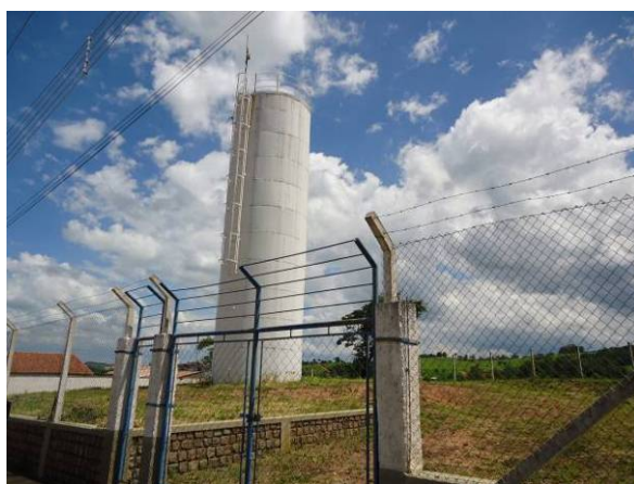
Figura 43. Vista do Reservatório R08
