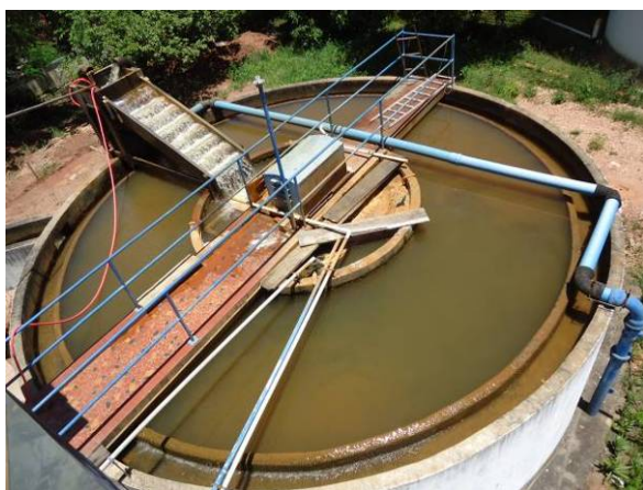
Figura 21. Vista da Estação de Tratamento de Água
