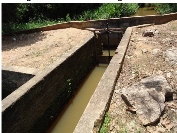
Figura 09. Vista da Captação Córrego da Vaca
