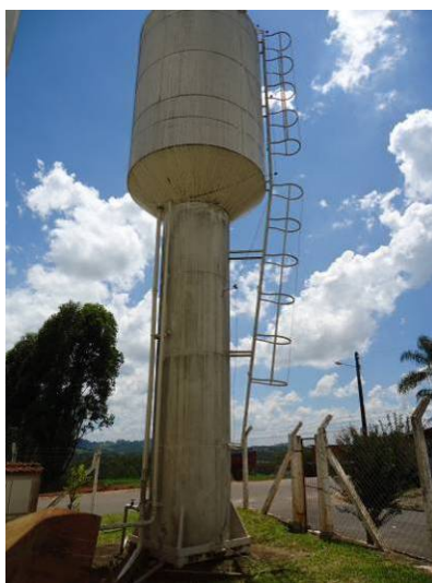
Figura 41. Vista do Reservatório R06
