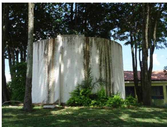
Figura 48. Vista do Reservatório R13
