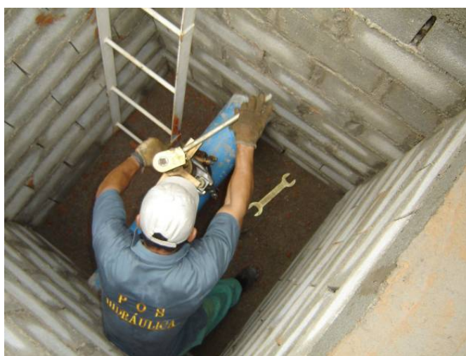
Figura 72. Momento em que a tubulação é furada
