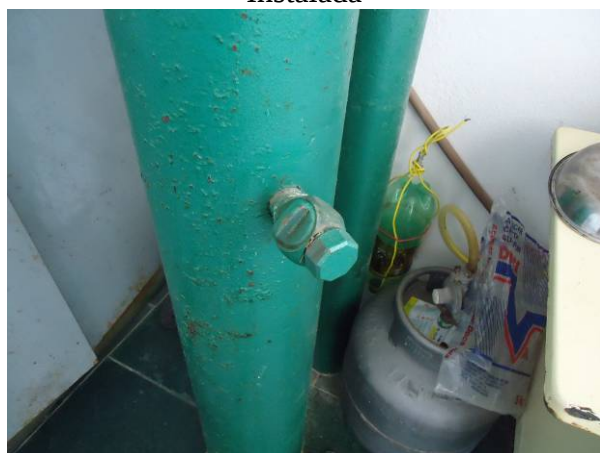
Figura 99. Vista da Estação Pitométrica Existente
