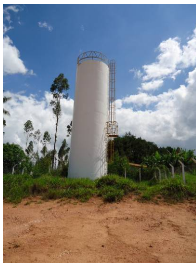
Figura 44. Vista do R09
