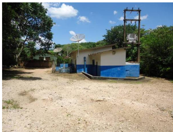
Figura 16. Vista da Estação Elevatória de Água
