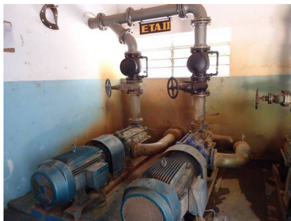
Figura 14. Vista do Conjunto Motor-Bomba que recalca água para a ETA II
