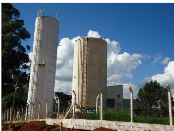
Figura 52. Vista dos Reservatórios em Barrânia
