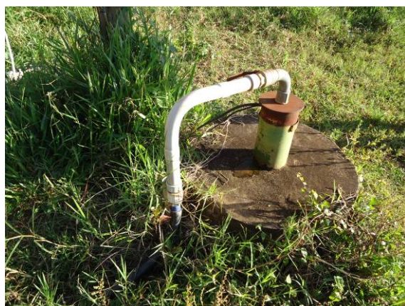
Figura 56. Vista do Poço Mirante
