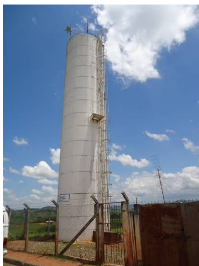
Figura 47. Vista do Reservatório R12
