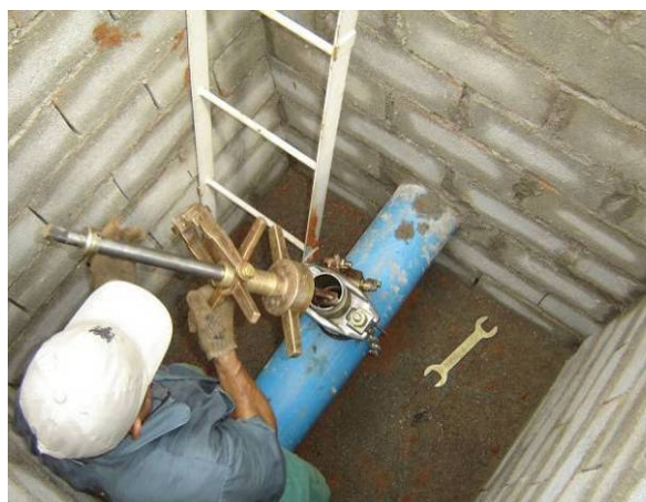
Figura 70. Colocação da máquina no suporte
