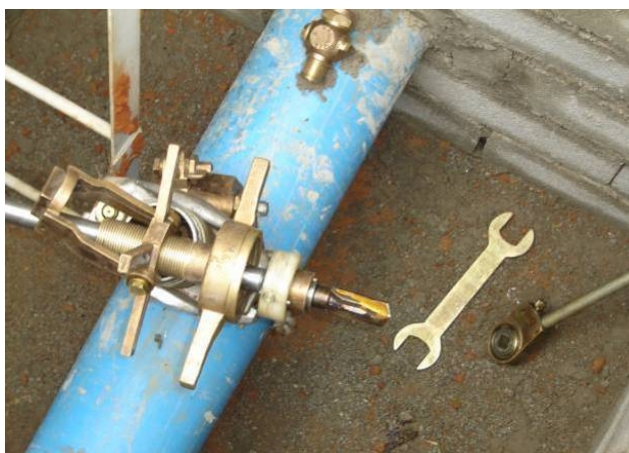
Figura 69. Broca encaixada na base da máquina
