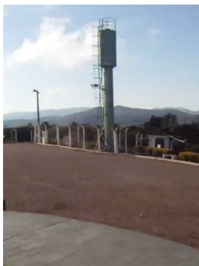
Figura 58. Vista do Reservatório Mirante
