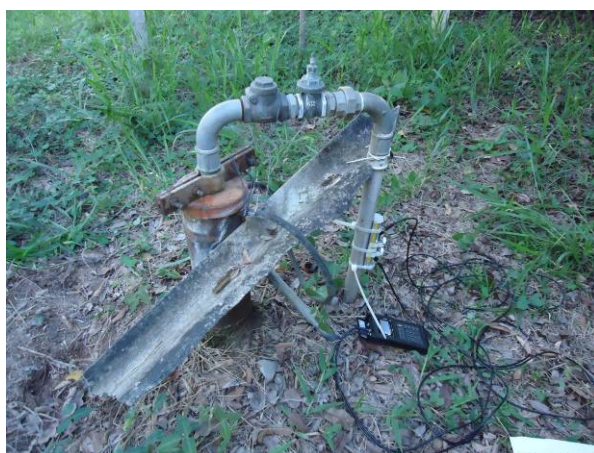
Figura 59. Vista do Poço Prainha
