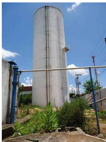
Figura 38. Vista do Reservatório R03
