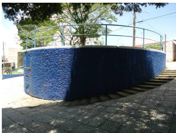
Figura 46. Vista do Reservatório R11
