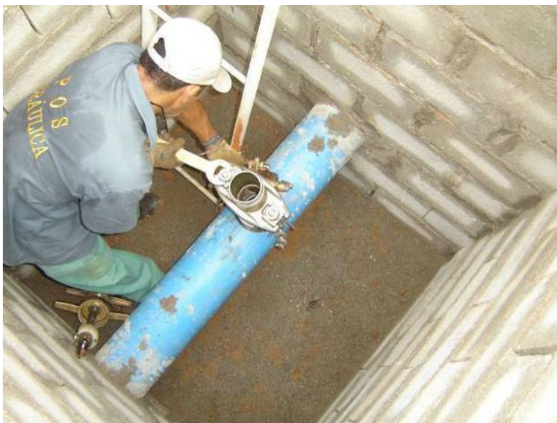
Figura 68. Colocação do suporte da máquina Miller
